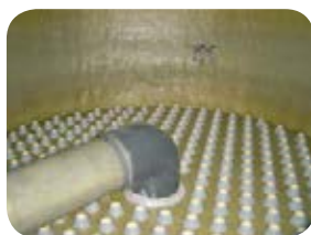
Plancher crépiné inférieur
